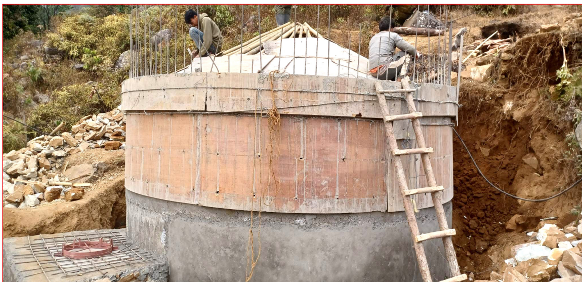
निर्माणाधिन खानेपानी ट्याङ्की
