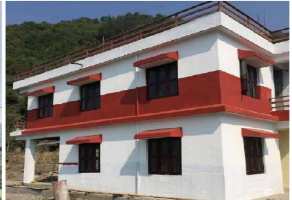
वडा नं ११ को निर्माणाधिन भवन
