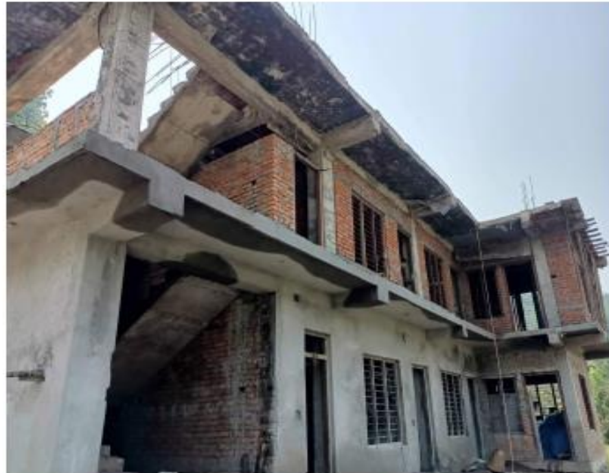
वडा नं ९ को निर्माणाधिन भवन
